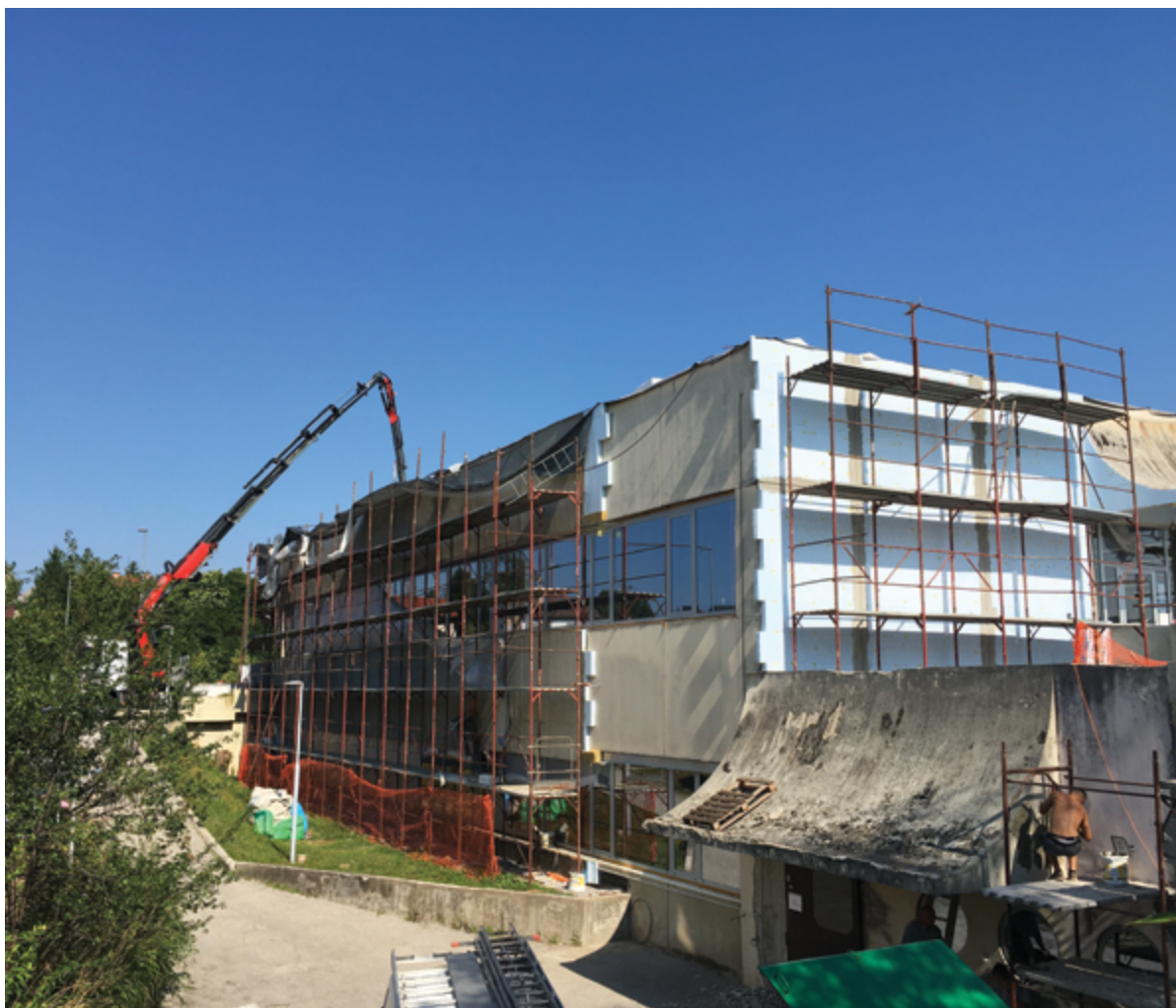
Stavba kuhinje z restavracijo Splošne bolnišnice NM med obnovo.
