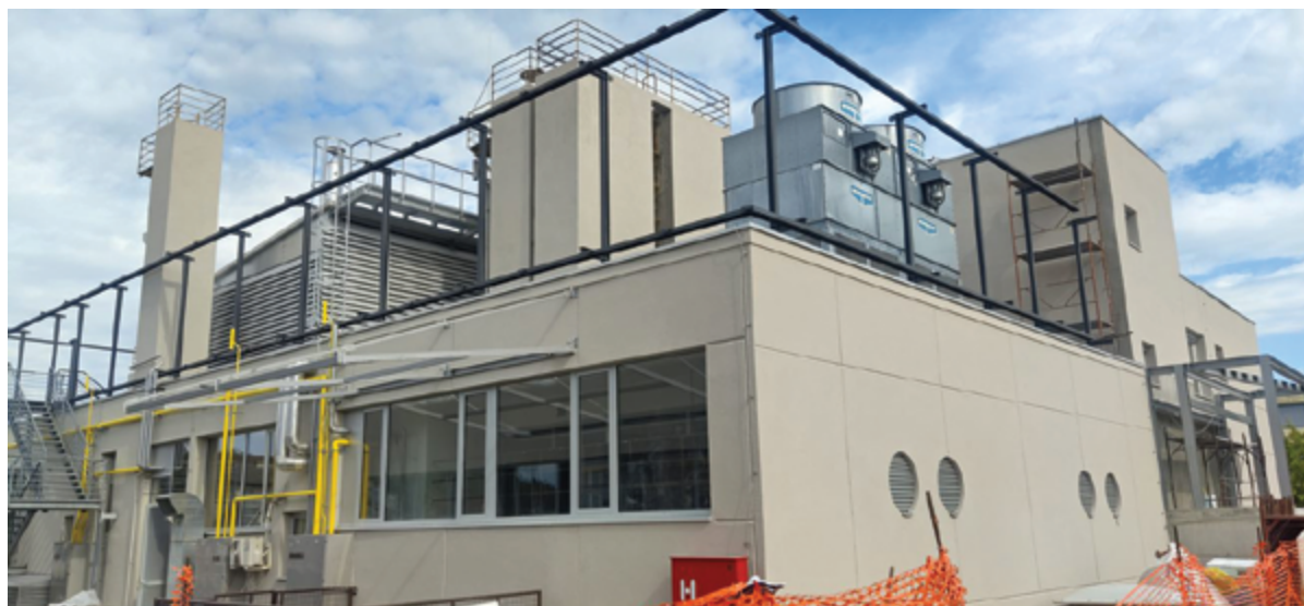
Izvedba podkonstrukcije za mrežasto ograjo iz ekspandirane pločevine.
